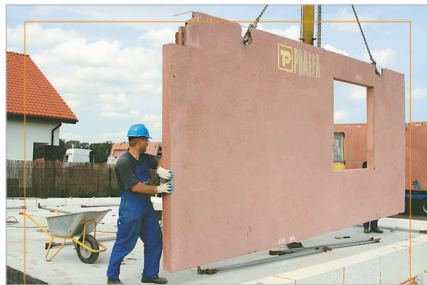
Montaż prefabrykatów keramzytobetonowych
