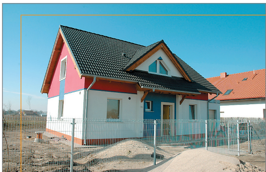
Realizacja domu pasywnego, Smolec 2007, widok od frontu
